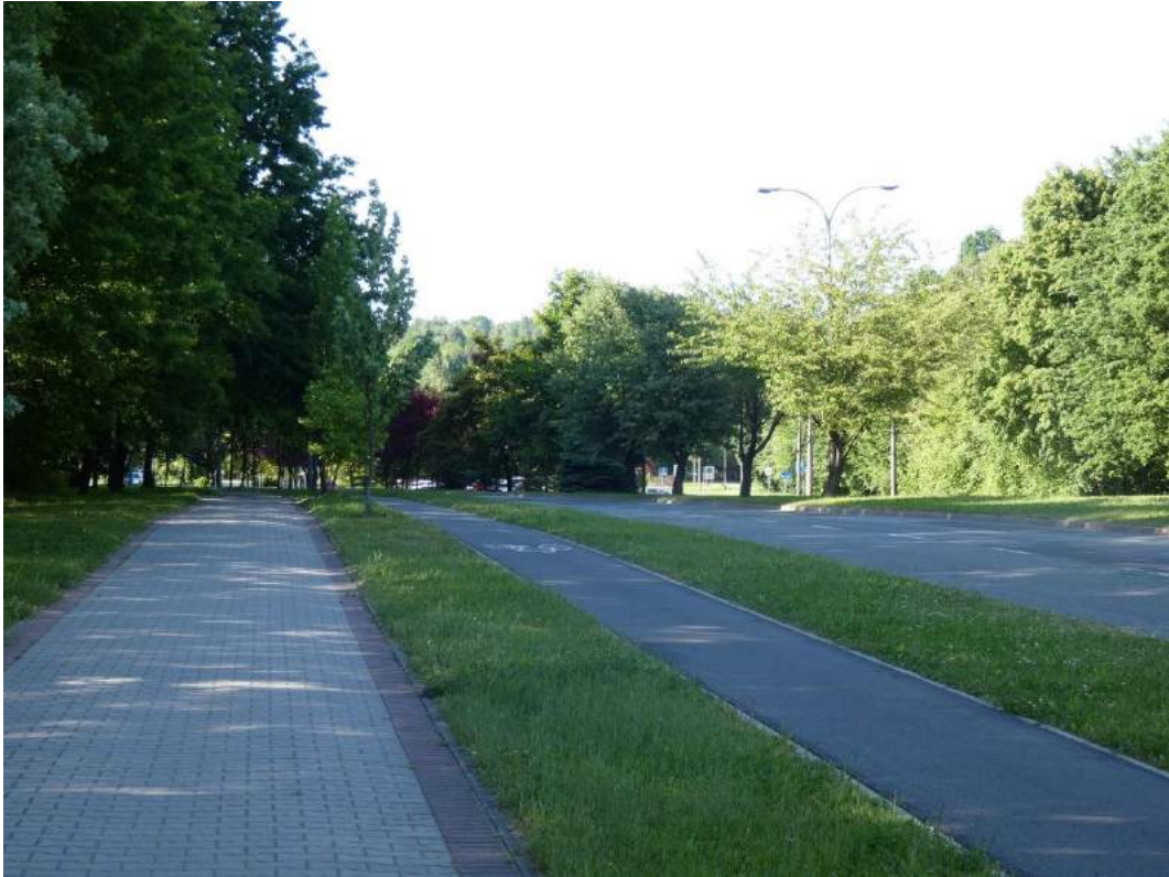
Fotografia 3.2 Infrastruktura dla pieszych i rowerów w Jastrzębie-Zdroju
