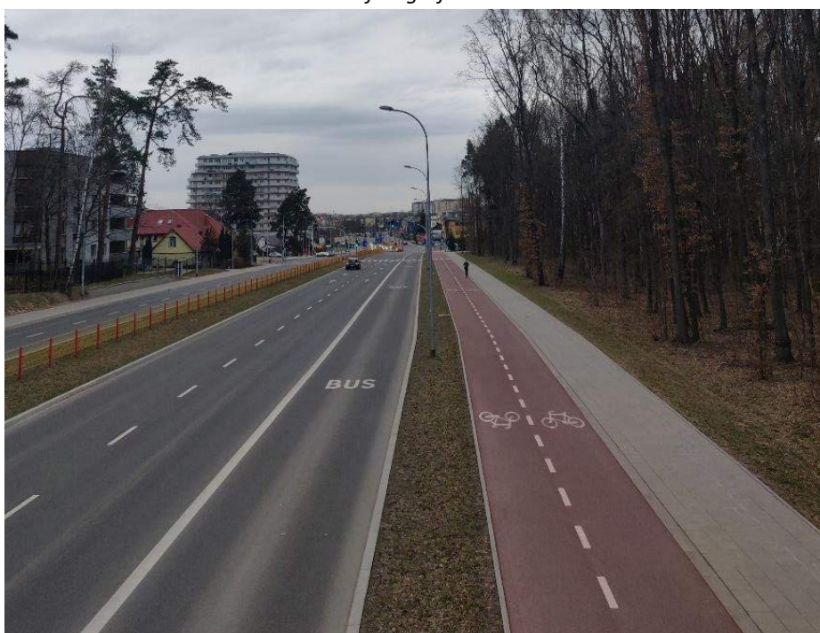
Fotografia 6.2 Pas autobusowy na odcinku prostym
