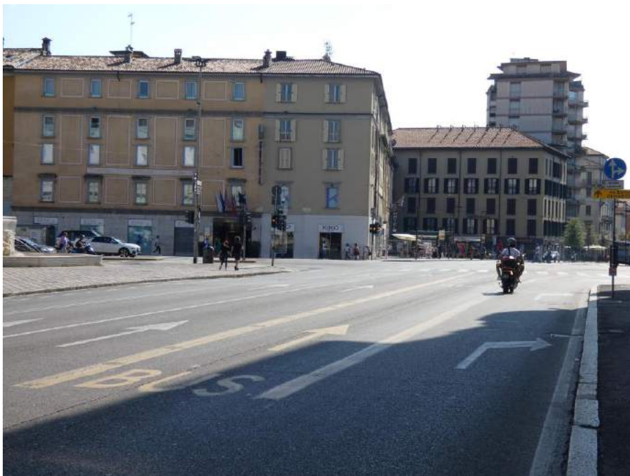
Fotografia 6.1 Pas autobusowy na wlocie skrzyżowania
