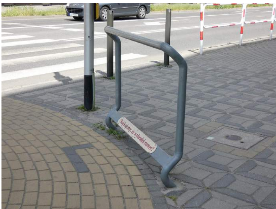
Fotografia 6.4 Podpórki na rowerzystów przy przejazdach rowerowych w Rybniku
