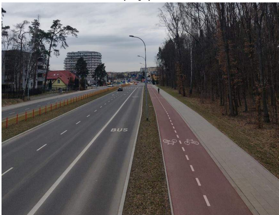
Fotografia 6.2 Pas autobusowy na odcinku prostym
