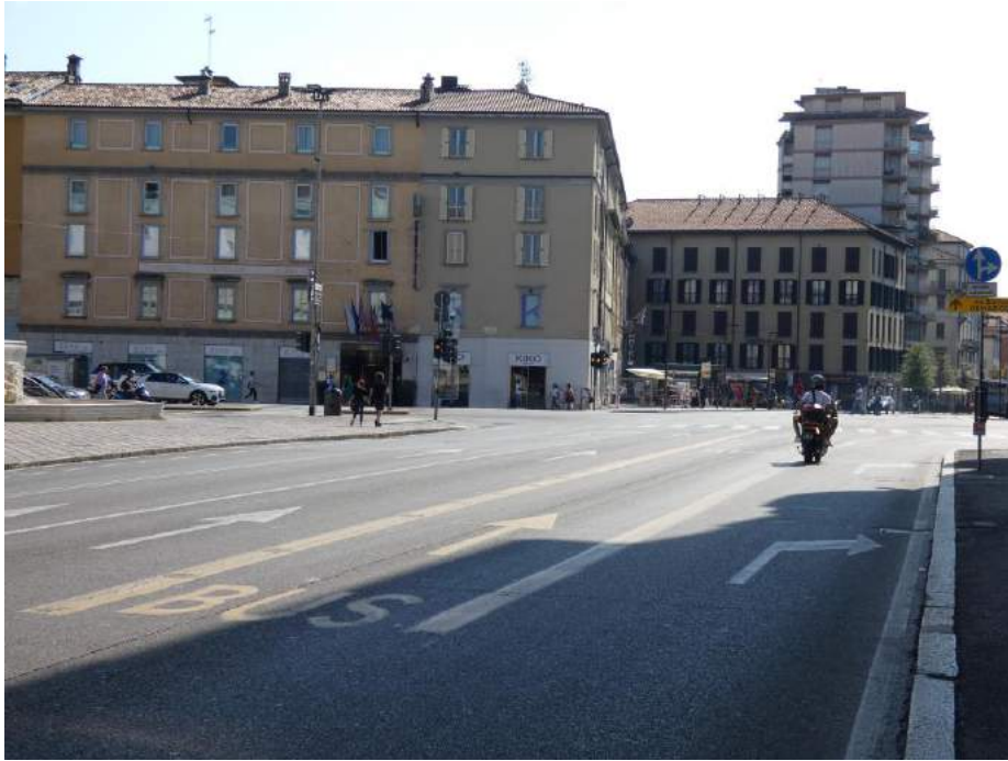
Fotografia 6.1 Pas autobusowy na wlocie skrzyżowania
