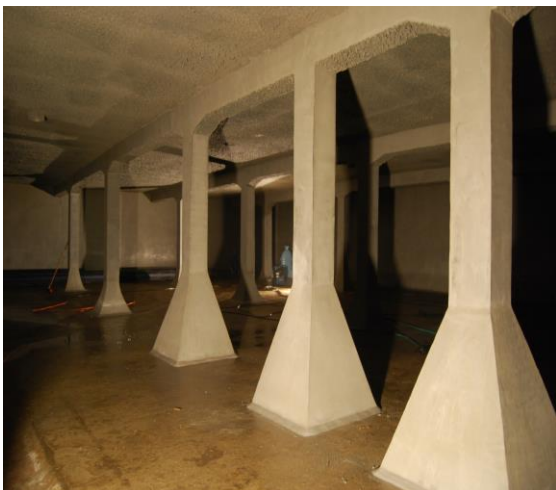
Rys. 4. Część układu technologicznego uzdatniania wody 1
